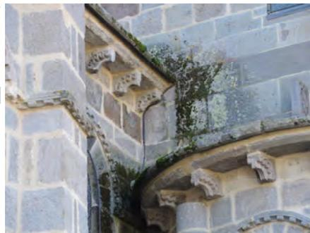
Fig. 10. Saint-Nectaire, écoulement d'eau, couvrement par cyanobactéries et lichens
